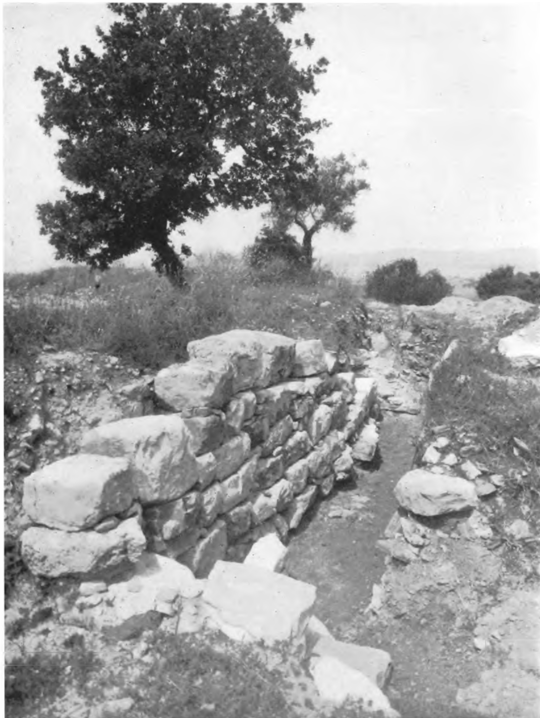
Scavi a Nord dell'anfiteatro: particolare del muro curvilineo a grossi blocchi, visto da Est; dietro si intravedono i blocchetti del muro di anagramma, in primo piano e in fondo i due speroni.
