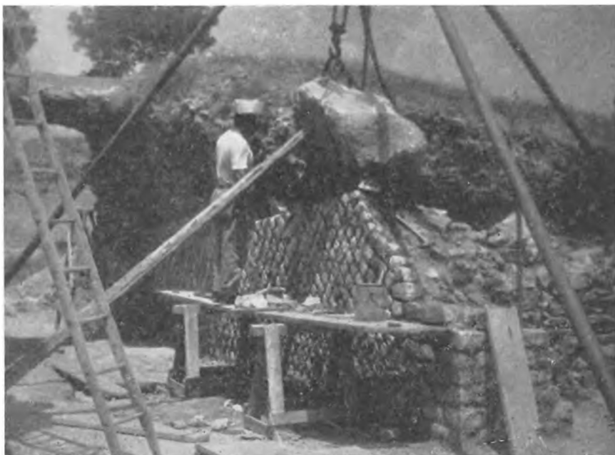
fig. 33: Si ricolloca il pezzo di volta caduto.
