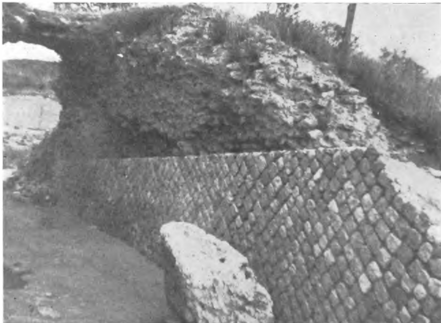
fig. 32: L'ingresso Sud dell'anfiteatro col pezzo di volta caduto.
