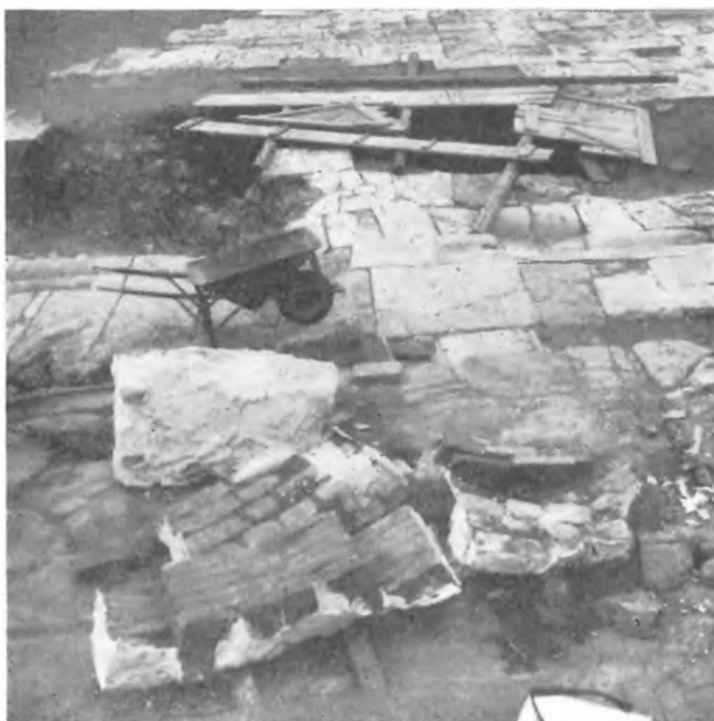
fig. 5: Sezioni del muro durante il restauro.
