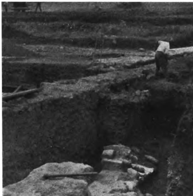
fig. 18: Le sostruzioni a Ovest della vasca poi demolite.
