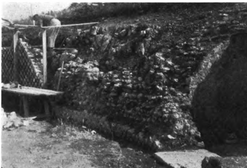
fig. 31: Il restauro del paramento reticolato del podio, nell'ultimo tratto del settore Sud-Ovest vicino all'ingresso del piccolo vano Sud-Ovest.
