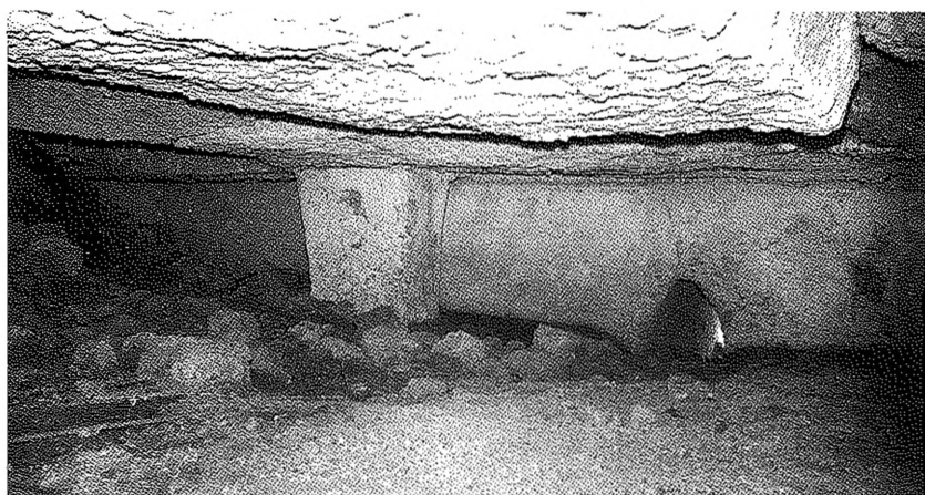
d) Vignale: cisterna con pilastri di sostegno e cunicolo per il deflusso dell'acqua.
