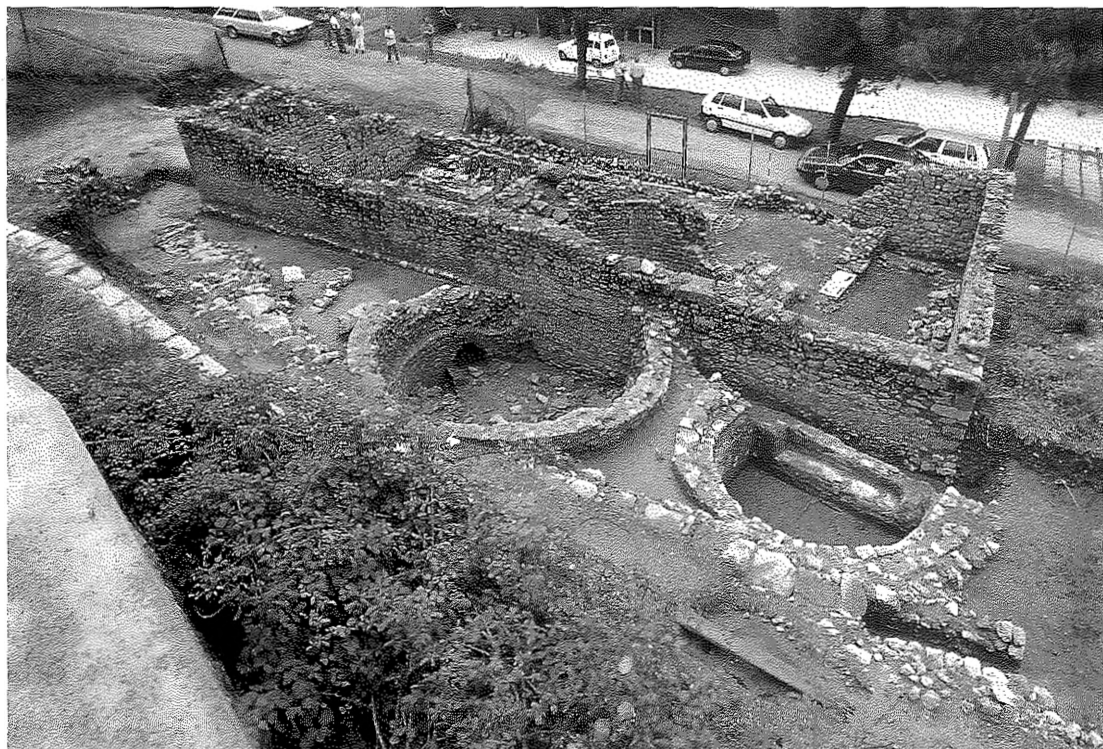
fig. 10 - Veduta delle terme di S. Felice, con la tettoia del 1785 (Guarnacci) parzialmente conservata.
