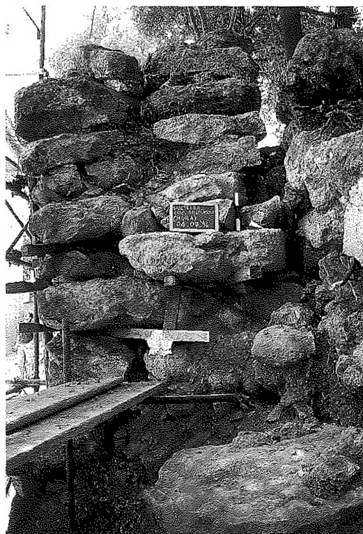
fig. 23 - Golfuccio: particolare della cinta urbana affiancata alla struttura precedente.
